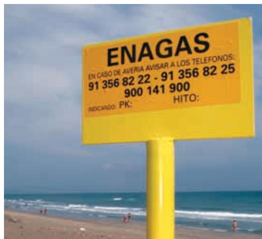
Señalización del trazado del gasoducto
